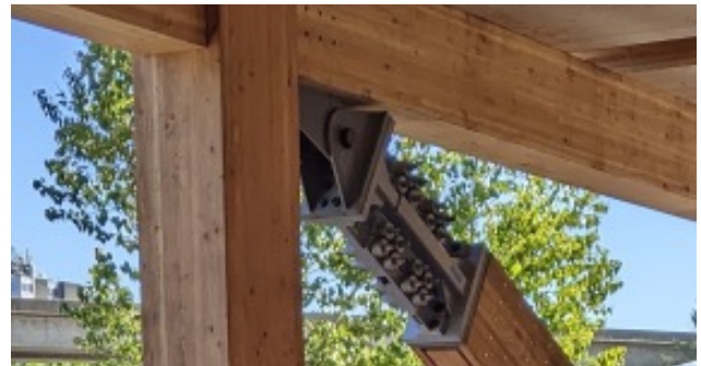
Image 11 - Connexions apparentes d'un bâtiment en bois massif.
