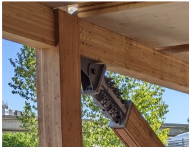
Image 11 - Connexions apparentes d'un bâtiment en bois massif.
