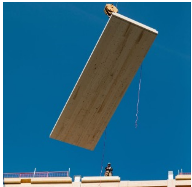
Image 2 - Installation d'un panneau de plancher en bois massif CLT durant d'une construction.
